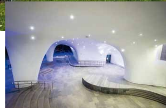
Фасады "Ледяной пещеры" в парке "Зарядье" выполнены из стеклофибробетона методом 3D-принтинга
