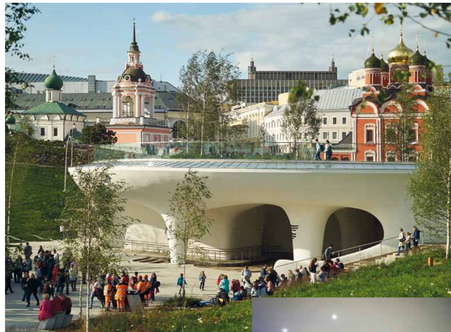
Фасады "Ледяной пещеры" в парке "Зарядье" выполнены из стеклофибробетона методом 3D-принтинга
