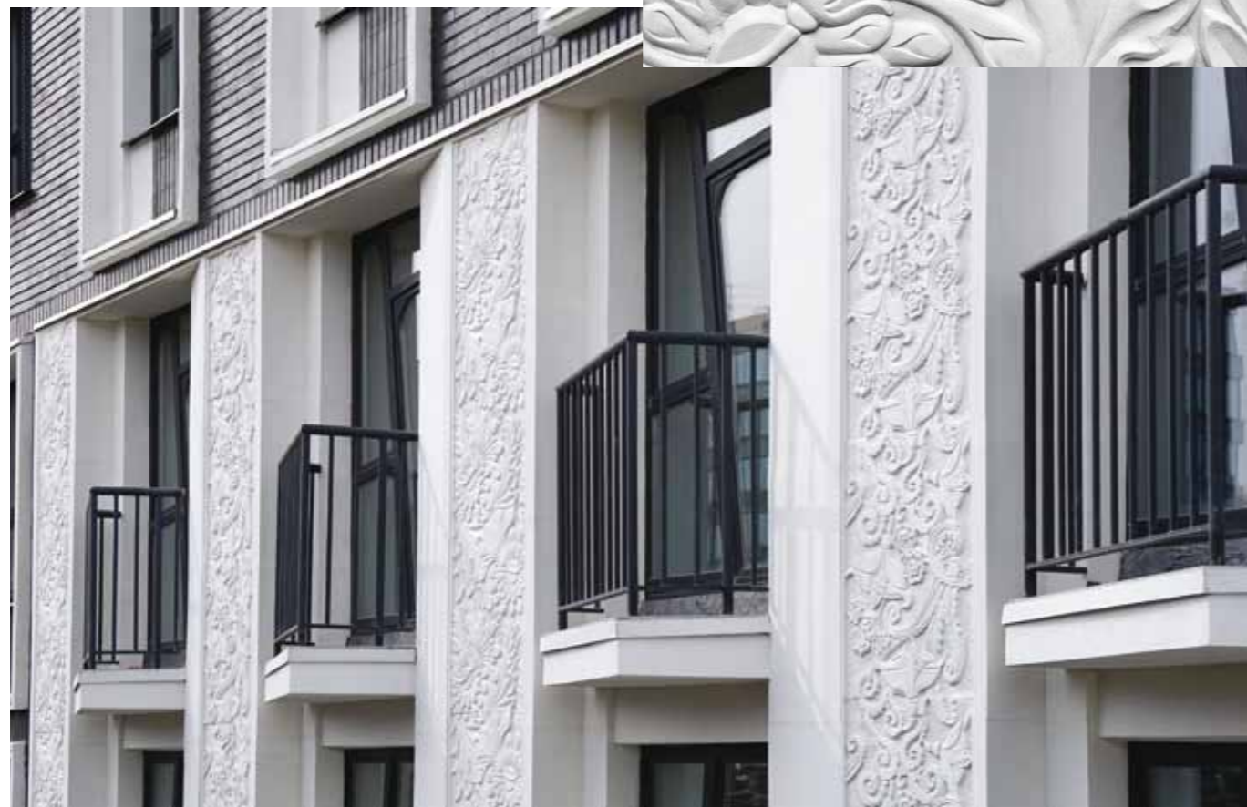
Панели из стеклофибробетона фабрики «Фиброль» на фасадах жилого комплекса «Невский»
