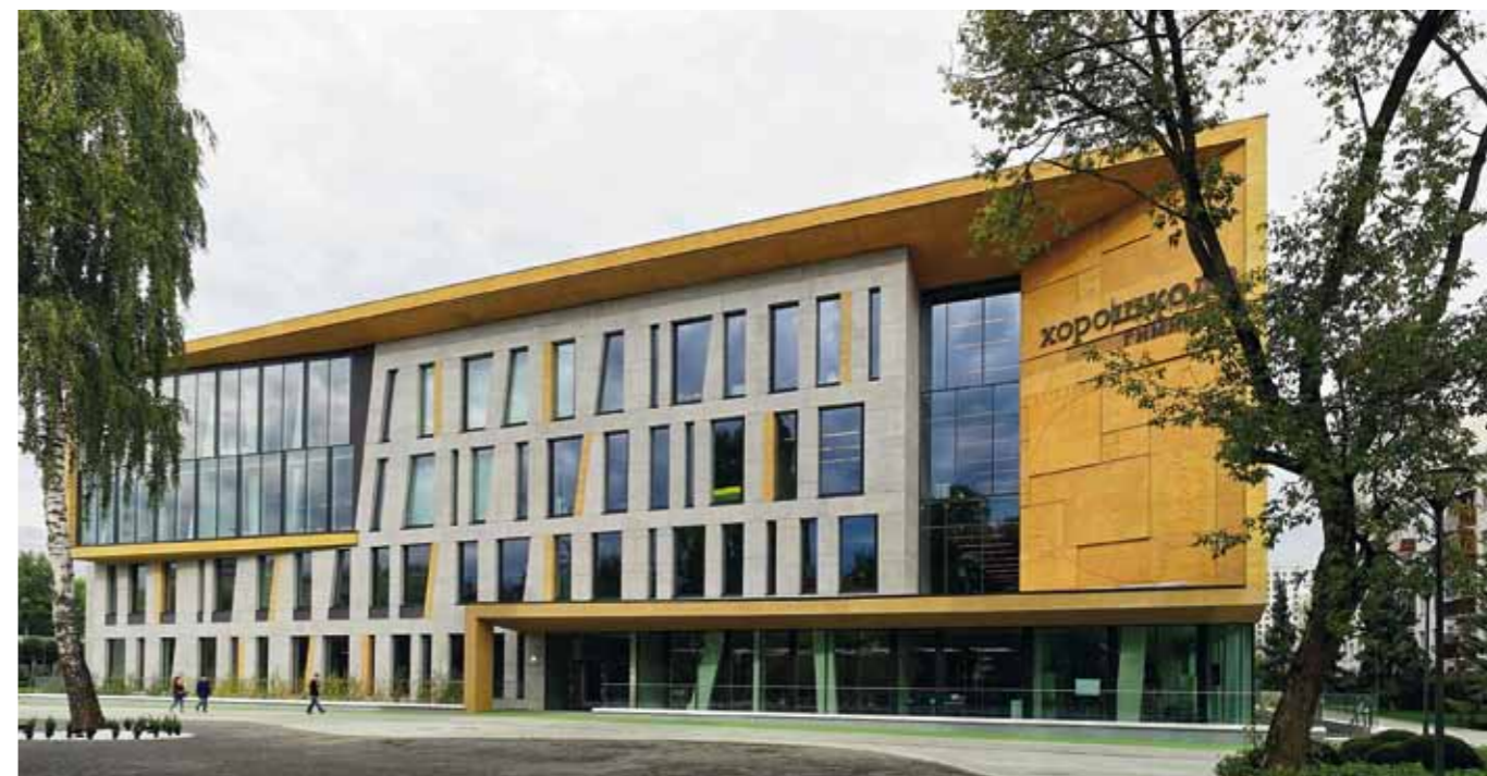
Фасады Хорошевской гимназии выполнены из фибробетонных панелей с имитацией фактуры травертина и дерева
